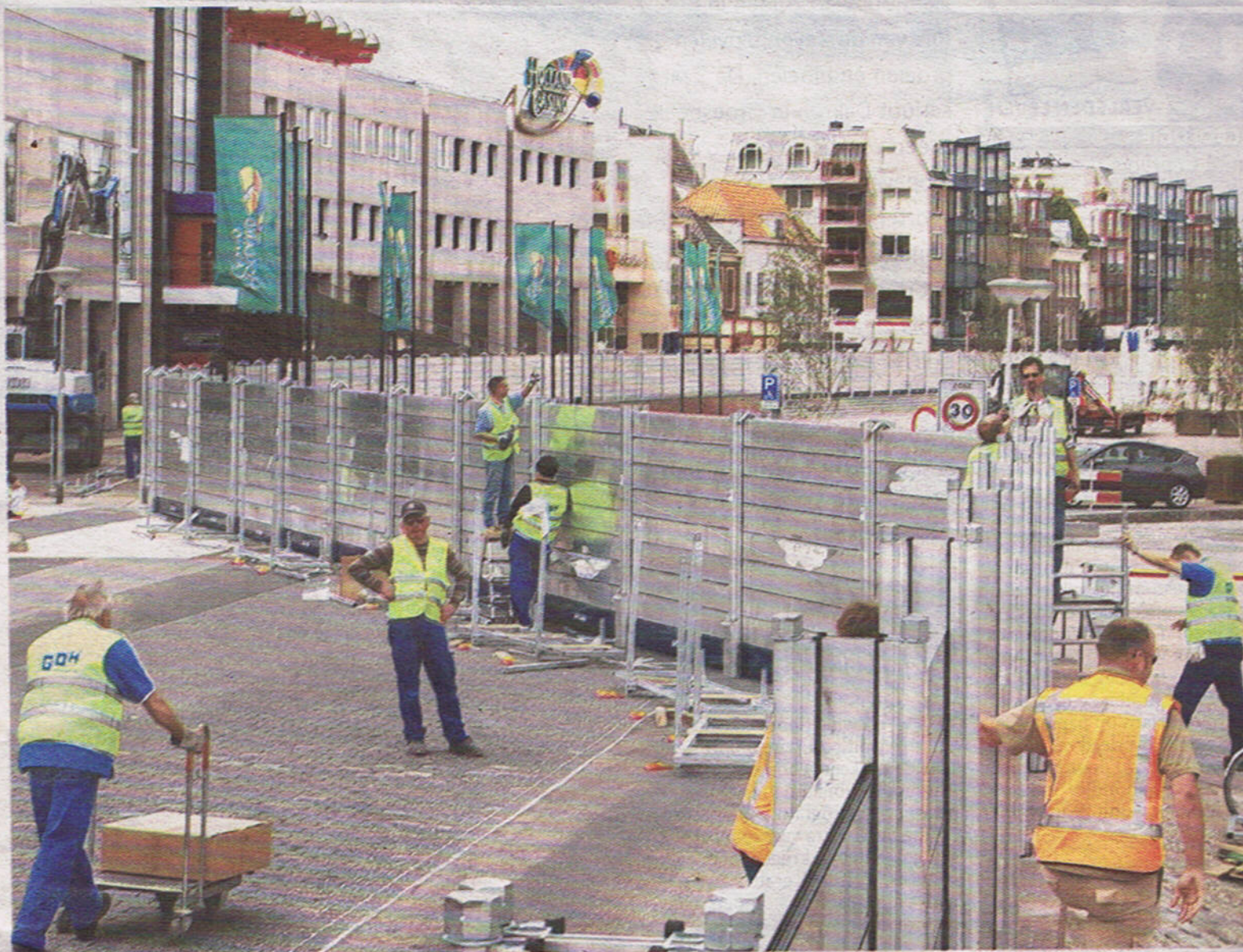
Er wordt nog steeds volop gewerkt aan de opbouw van de flexibele kademuur ter hoogte van het casino.
